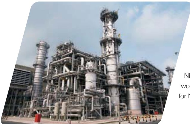
An LNG plant for Nigeria LNG Ltd., Nigeria
